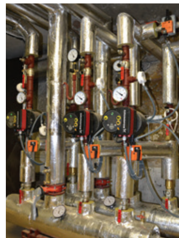
Rekonstruovaný rozdělovač/sběrač na ZŠ J. Harracha v Jilemnici
