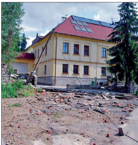
Liberec: Město vyčíslilo jen škody na komunikacích na několik desítek milionů korun...
