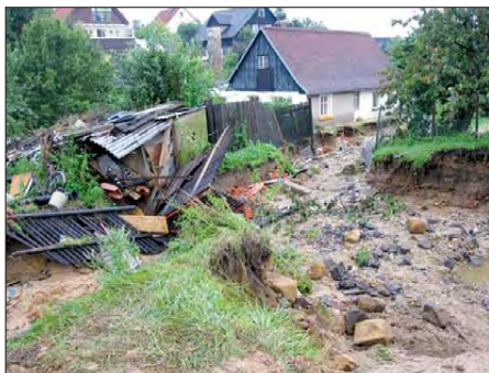
Jablonné v Podještědí: Voda zde strhla svah u silnice na více místech a razila si cestu dále.
