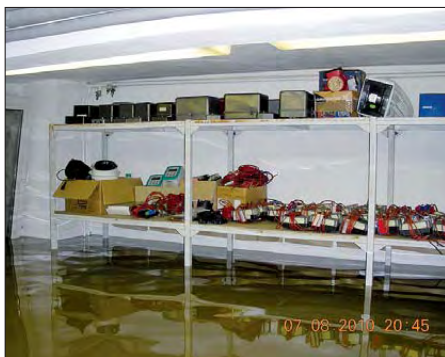
Děčín: Voda napáchala škody i kvůli zvednuté hladině spodních vod ve městě. Na snímku je sídlo společnosti TERMO Děčín.
