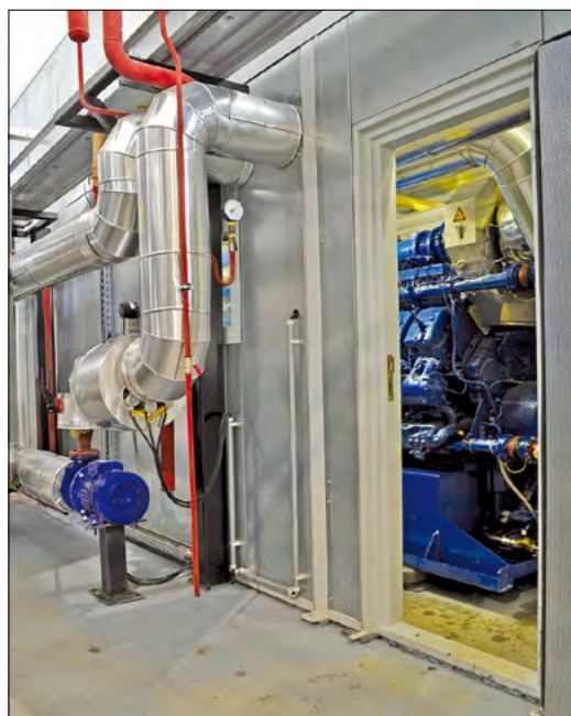
Všech pět motorů projektu GOGEN II je umístěno v protihlukových boxech.
