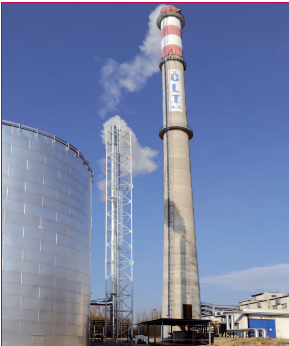
Proměna areálu ve Staré Lípě: starou nevyužívanou uhelnou kotelnou nahradila moderní hala, ve které jsou tři kogenerační motory vyrábějící elektřinu a teplo. V novém areálu je také umístěna obří nádrž akumulující vyrobené teplo.
